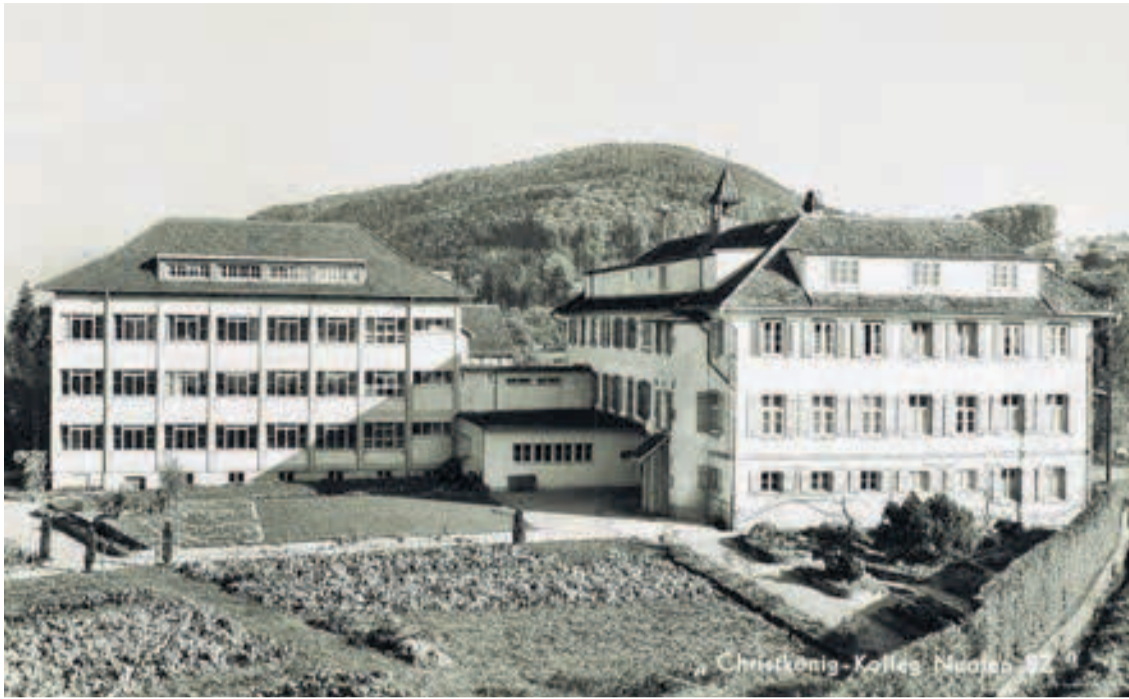
Das Christ-König-Kollegium Nuolen mit der ersten baulichen Erweiterung, dem 47er-Bau.
